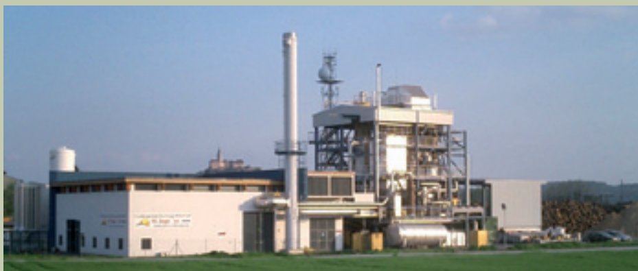
Kraftwerk Güssing, Photo: Güssing
