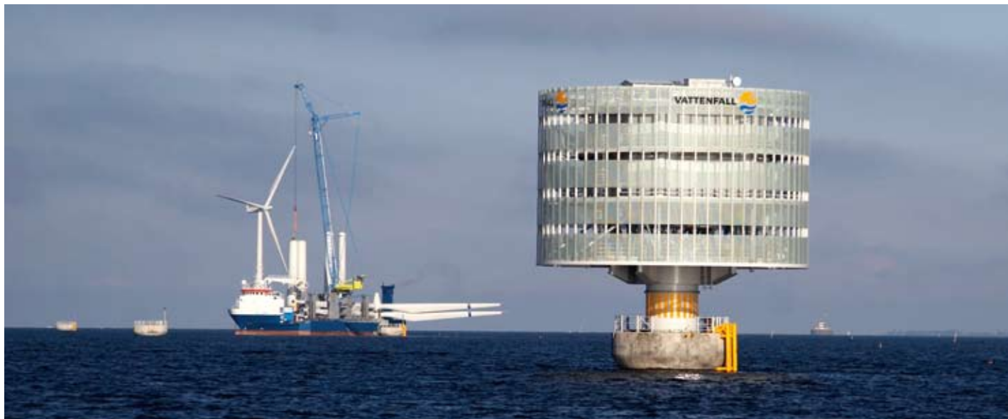
The construction of the Lillgrund wind farm. Photo: Vattenfall
