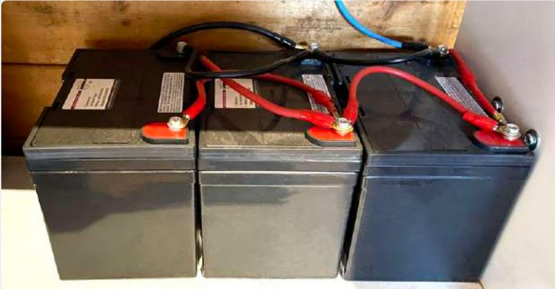
Bild 3. Drei 12-V-Blei-Gel-Akkus mit je 36 Ah parallelgeschaltet als Energiespeicher im Gartenhäuschen von Klaus.
